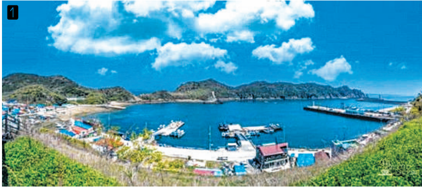
1. 군산 어청도 전경 2. 등록문화재 제378호 등대 3. 프리미엄급 여객선 어청카훼리호 모습
